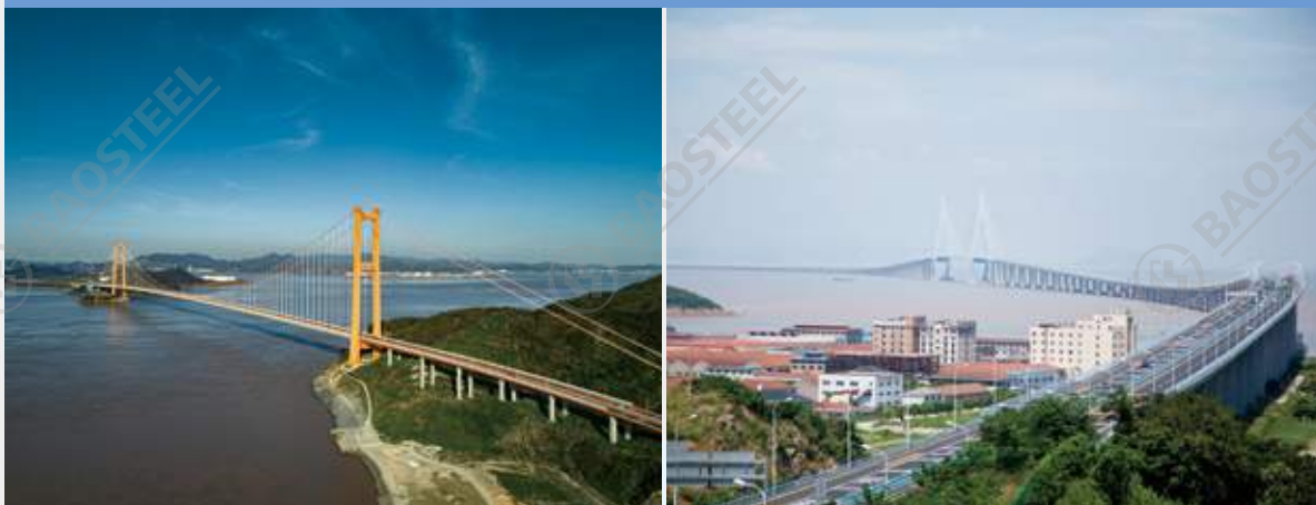
项目名称： 舟山市大陆连岛工程 project: Zhoushan mainland Island connection project
