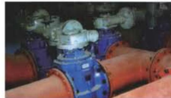
图3弹性座封偏心旋塞阀应用现场
